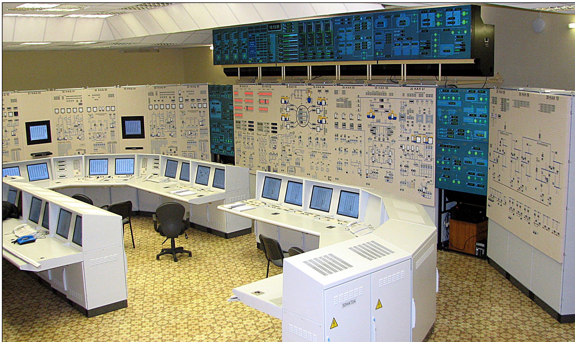
Полномасштабный тренажер блока №3 Калининской АЭС
